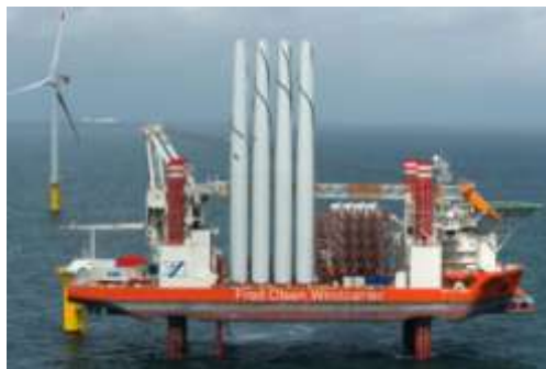
圖 85 大型自升式運輸安裝船
