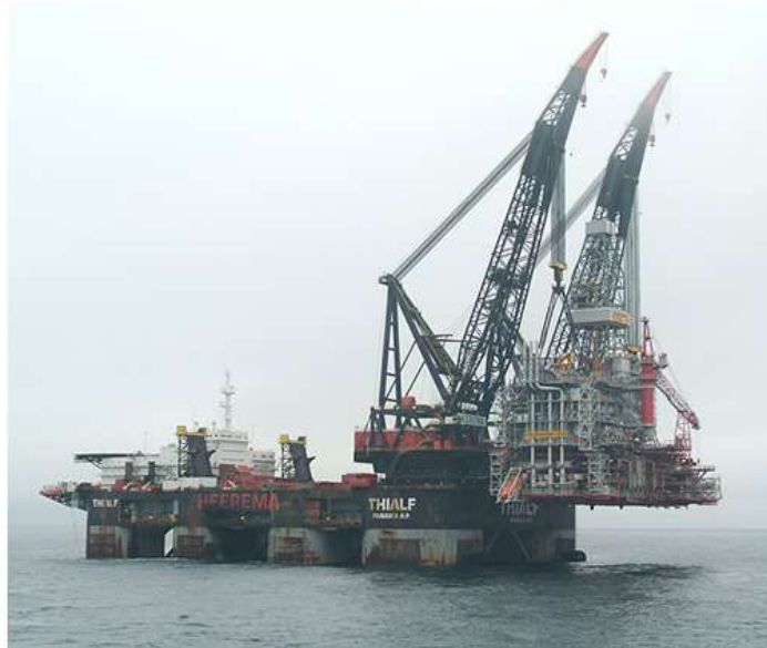
圖 17 雙鉤起吊情況
