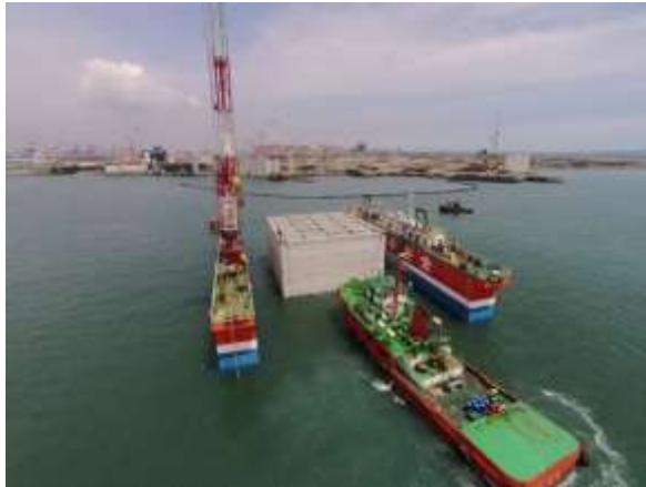
圖 75 取沉箱浮沉台運送安裝基礎或風力機。
