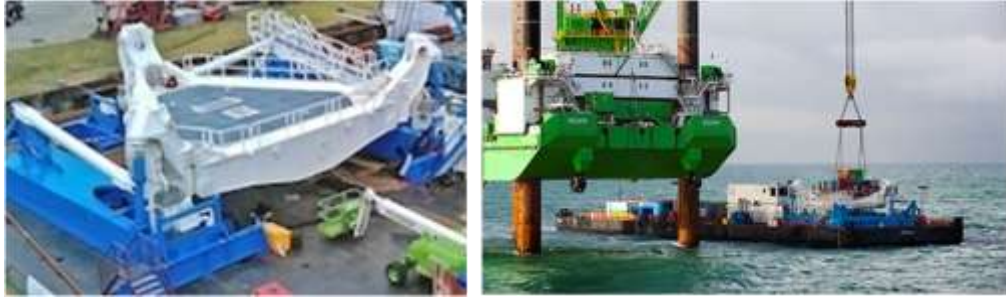
圖 83 方法二：一艘補償台運輸船運輸、一艘自升式平台現場安裝
