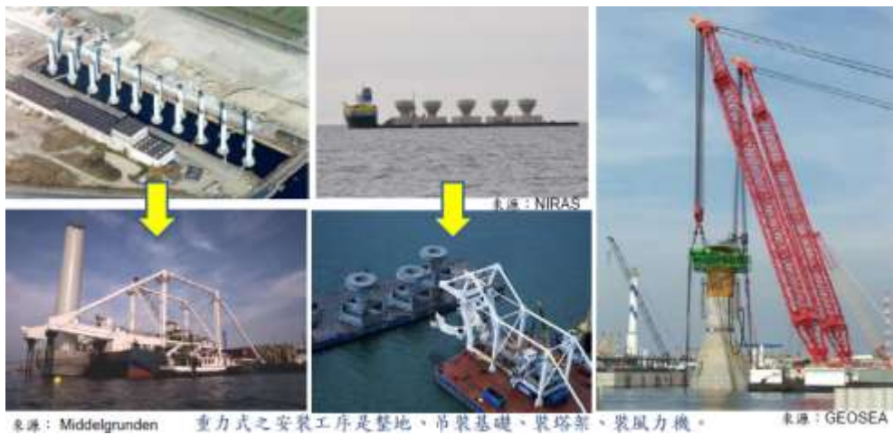
圖 52 重力式混凝土基礎之安裝工序
