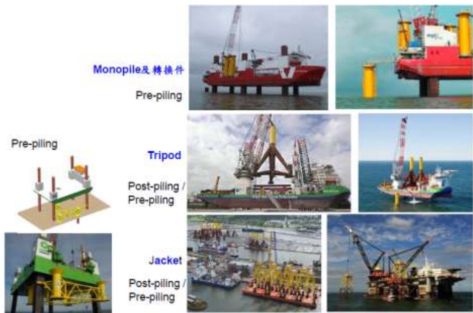
圖 51 各式鋼構基礎之安裝工序
