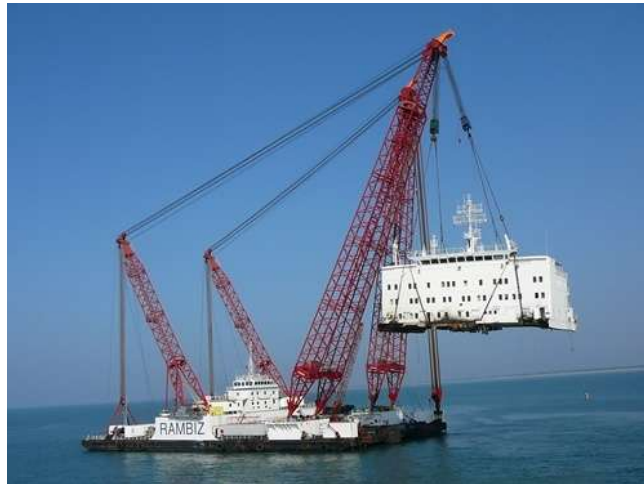
圖 16 四條鋼索吊裝情況
