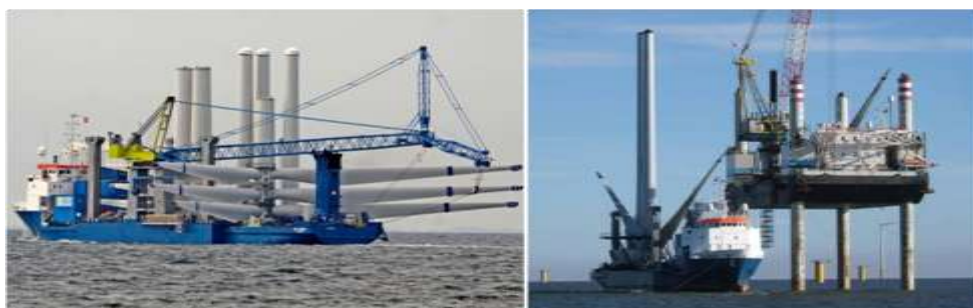
圖 82 方法一：一艘半升式船穿梭運輸、一艘自升式平台現場安裝
